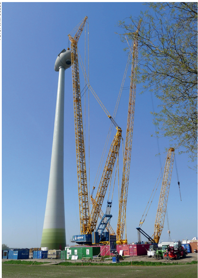
FIGUUR 1: AANBOUW VAN WINDMOLEN DE AMBTENAAR IN DE WIERINGERMEER NABIJ MEDEMBLIK. DE WINDMOLEN HEEFT EEN VERMOGEN VAN 7.5 MW EN LEVERT ENERGIE VOOR 13.000 INWONERS. DE WIEKEN REIKEN TOT 200 M HOOGTE.
